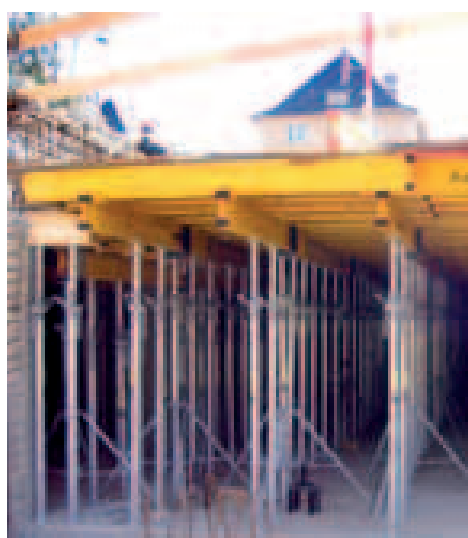
Puntal EP en el apeo del Encofrado Horizontal ENKOFLEX
