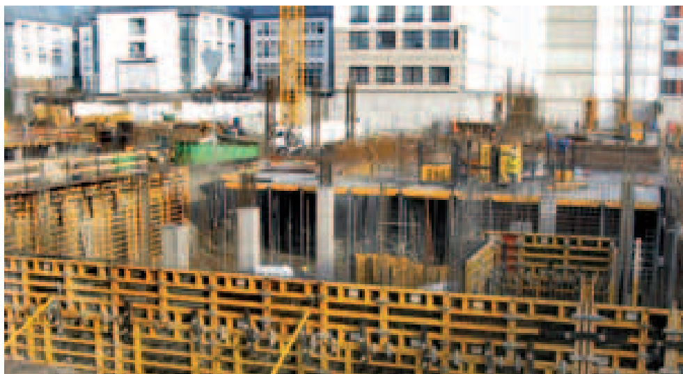
Puntal EP apeando el Encofrado Horizontal CC-4
